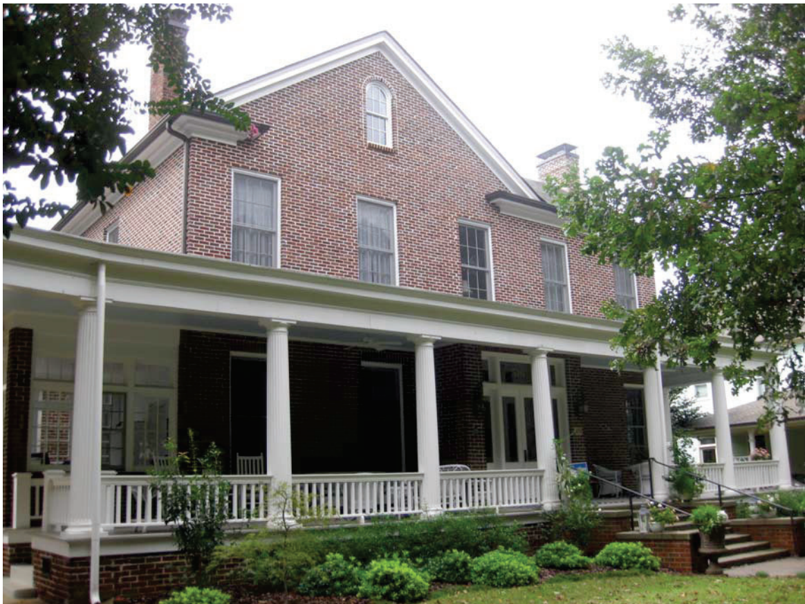
2 Exterior NE Corner
