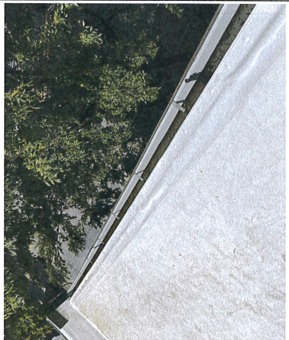
Gutter/drip edge metal ( Top Side)
